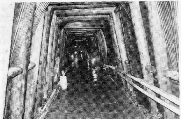
足尾銅山跡 400年にわたり掘り開いた坑道の総延長は1,234km (東京-博多間) に達するとの事
